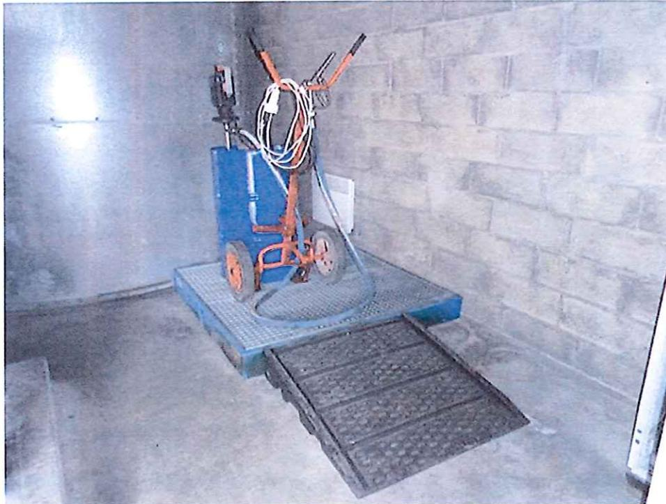
**Mise en place de la réserve de Gasoil sous rétention dans un emballage en métal.**
